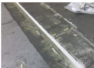
打ち継ぎ目地の補修
