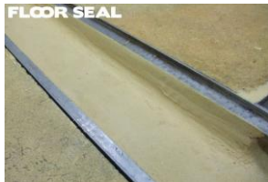
破損した側溝の補修に
