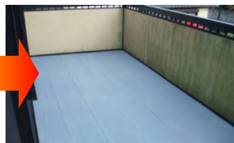
ベランダ塗布後
